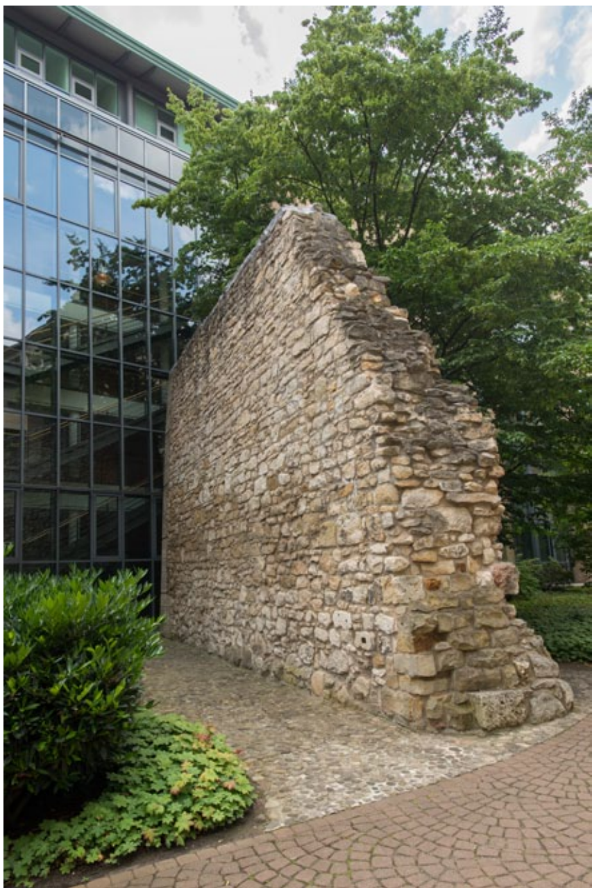
Blick auf die Außenfassade des Neubaus mit der historischen Stadtmauer
